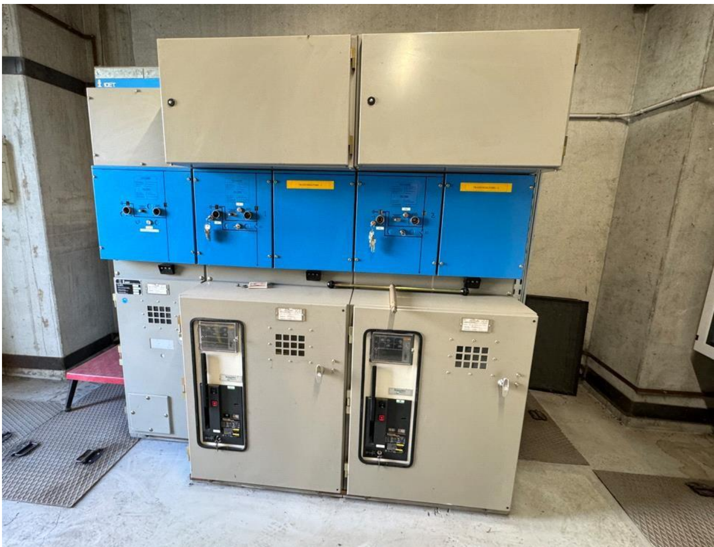
Figura 1 cabina di trasformazione esistente
